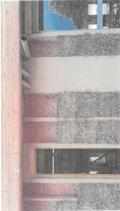
Crèche Les Petits Pieds de Ruelle : mise en œuvre de l'isolant en poille dans la structure en bois.
